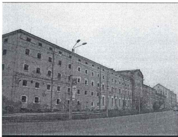
A szeszgyár 1851-ben átadott épülete ma
